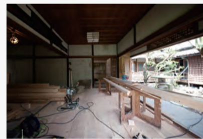
101号室 工事中の様子。当時の姿を尊重しつつ、リノベーションを行う。
